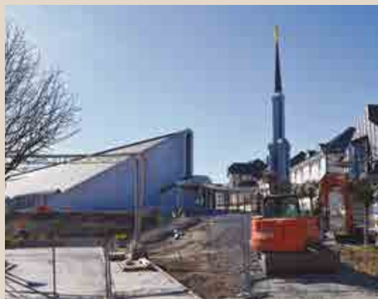
Die Baustelle des Frankfurt-Tempels
