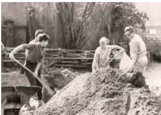
Der gemeinsame Umbau
